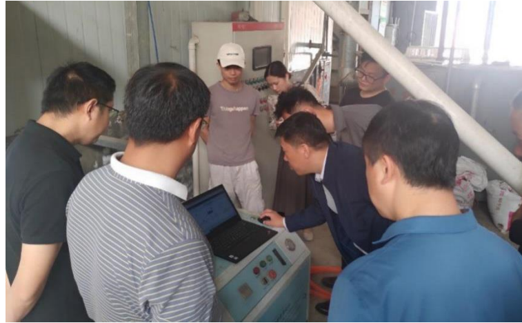
在养殖鸡舍现场安装、调试远程监控物联网设备与大数据平台
